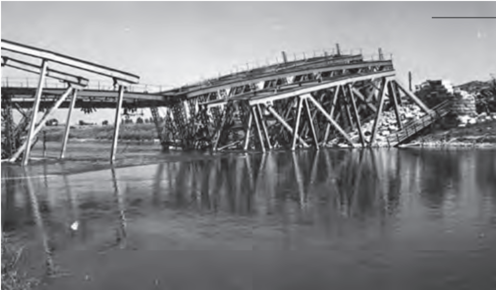
Spoorbrug over de Rijn bij Arnhem
